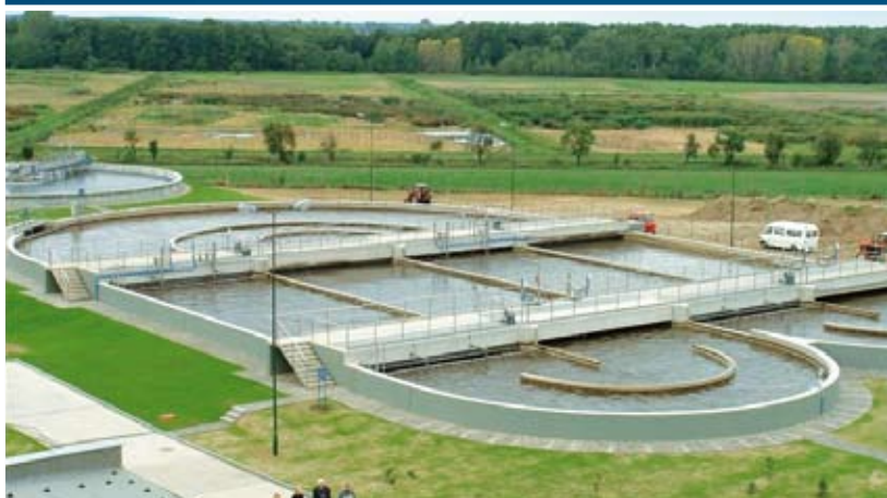
GMINNA OCZYSZCZALNIA ŚCIEKÓW 2003 rok
